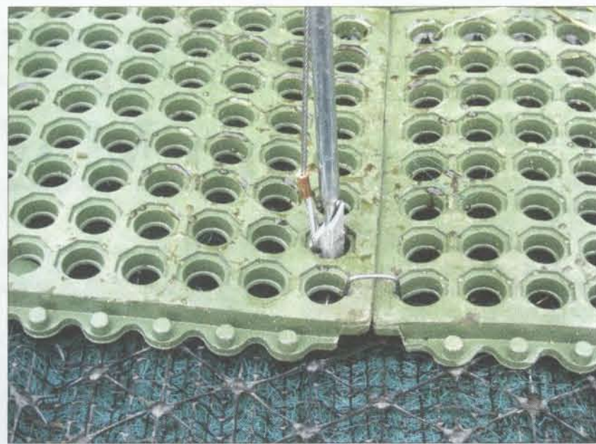
Die UV-stabilisierte Gummimatte für besonders erosionsgefährdete Stellen kann mit Erosionsschutzmatten oder Kokoswalzen verbaut werden.
