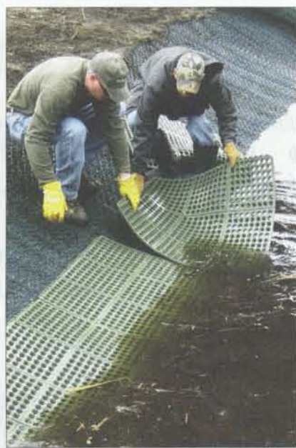
Das ShoreMax-System in Kombination mit Erosionsschutzmatten gegen Wellenschlag.
