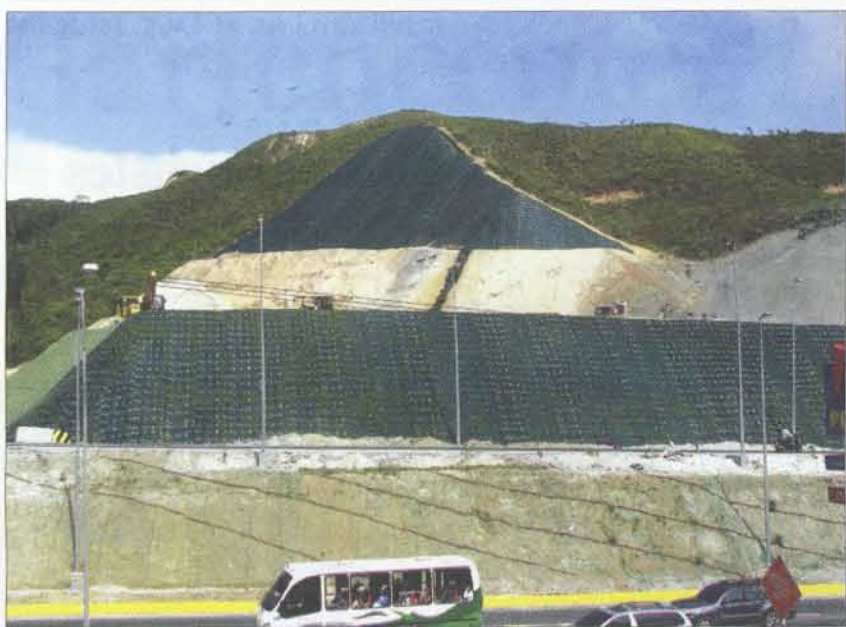
Als Alternative zu herkömmlichen Steinschüttungen und Betonauskleidungen bieten sich die Erosionsschutzmatten an.
