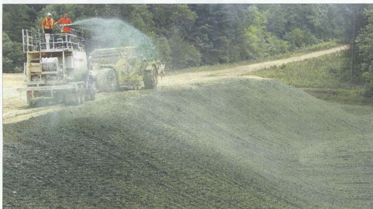
Böschungsbegrünung mit einer Anspritzmischung. Dabei ist gute Keimfähigkeit wichtig für schnelles Wachstum der Gräser und Kräuter.
