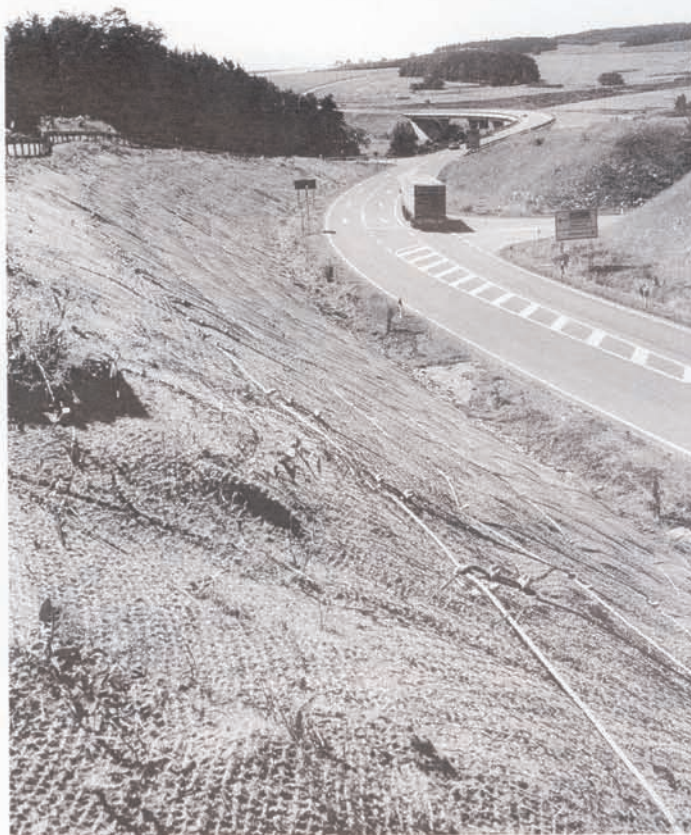
Geotextilien aus Kokosfasern stabilisieren eine erosionsgefährdete Böschung bis zur vollständigen Begrünung, bevor sie sich selbst in Humus auflösen.
