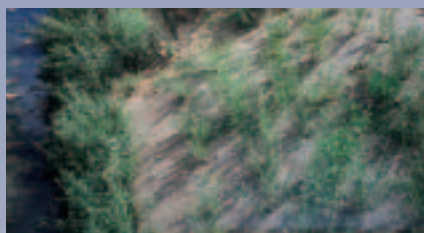
Begrünung und Erosionsschutz des Uferberei- ches mit gewebeverstärkter Spezialfasermatte Greening and erosion protection at the water- line using a coir fibre blanket strengthened by an integrated woven coir fabric
